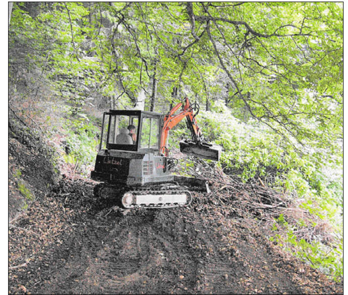
Der Kleinbagger von Bernd Wetzel schürfte die humusierte Bodenaufgabe von dem alten, ursprünglichen Wegeprofil. So erst konnte die einstige Weganlage wieder „hervor geholt“ werden. Bilder: sis
