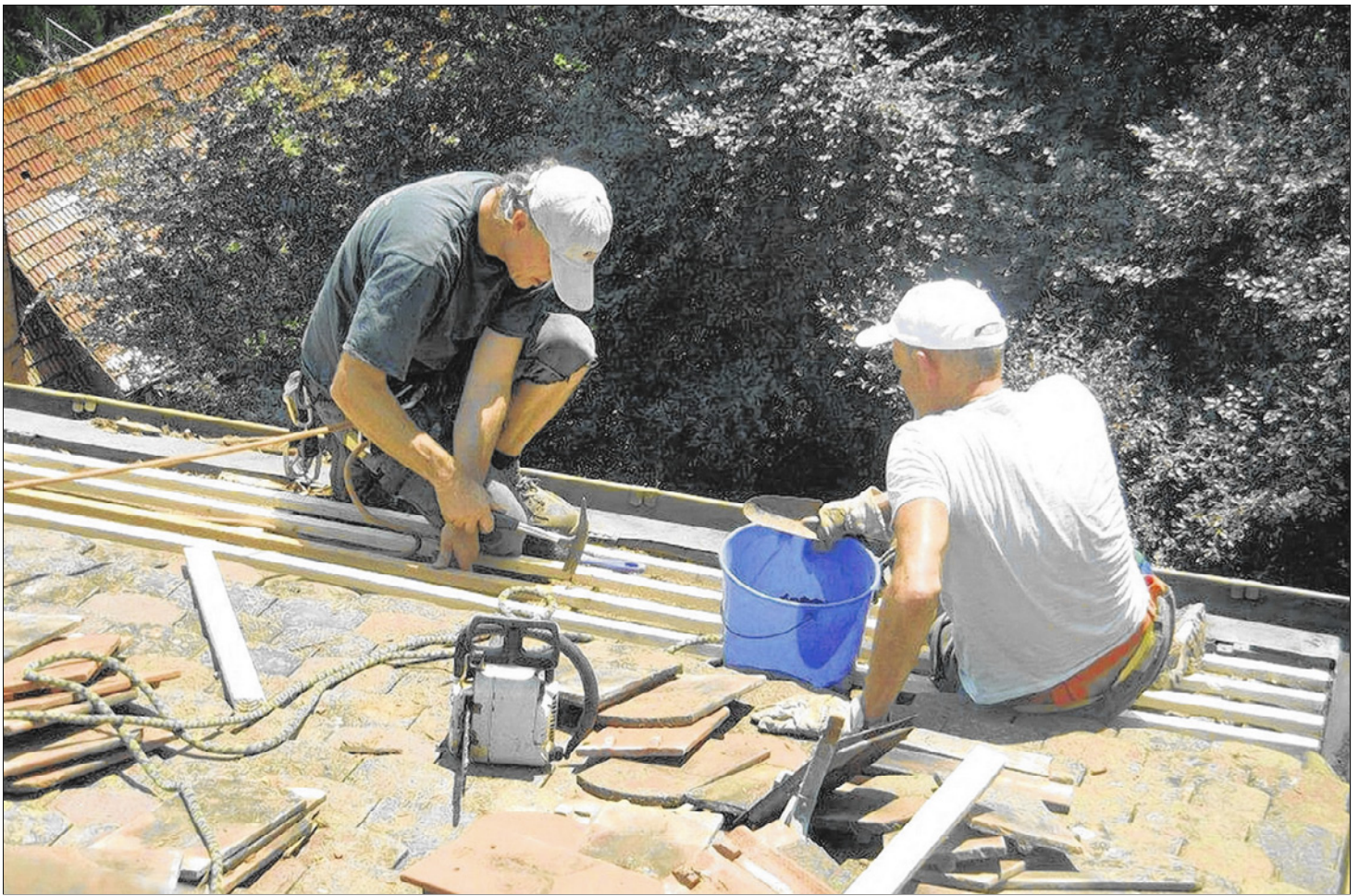
Reparatur-Arbeiten unter sengender Juli-Sonne auf dem höchsten Dach der „Waldlust“. Ziegel müssen ausgetauscht und Schadstellen ausgebessert werden. Bild: sis
